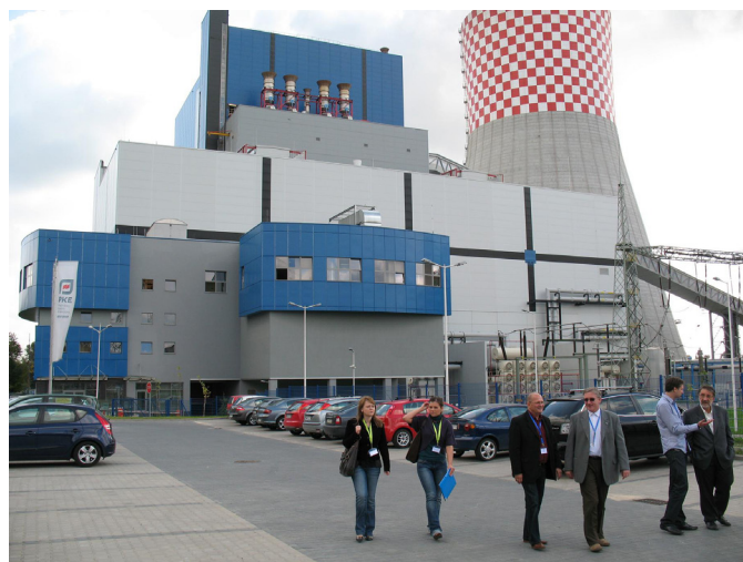
Widok ogólny nowego bloku w Elektrowni Łagisza
